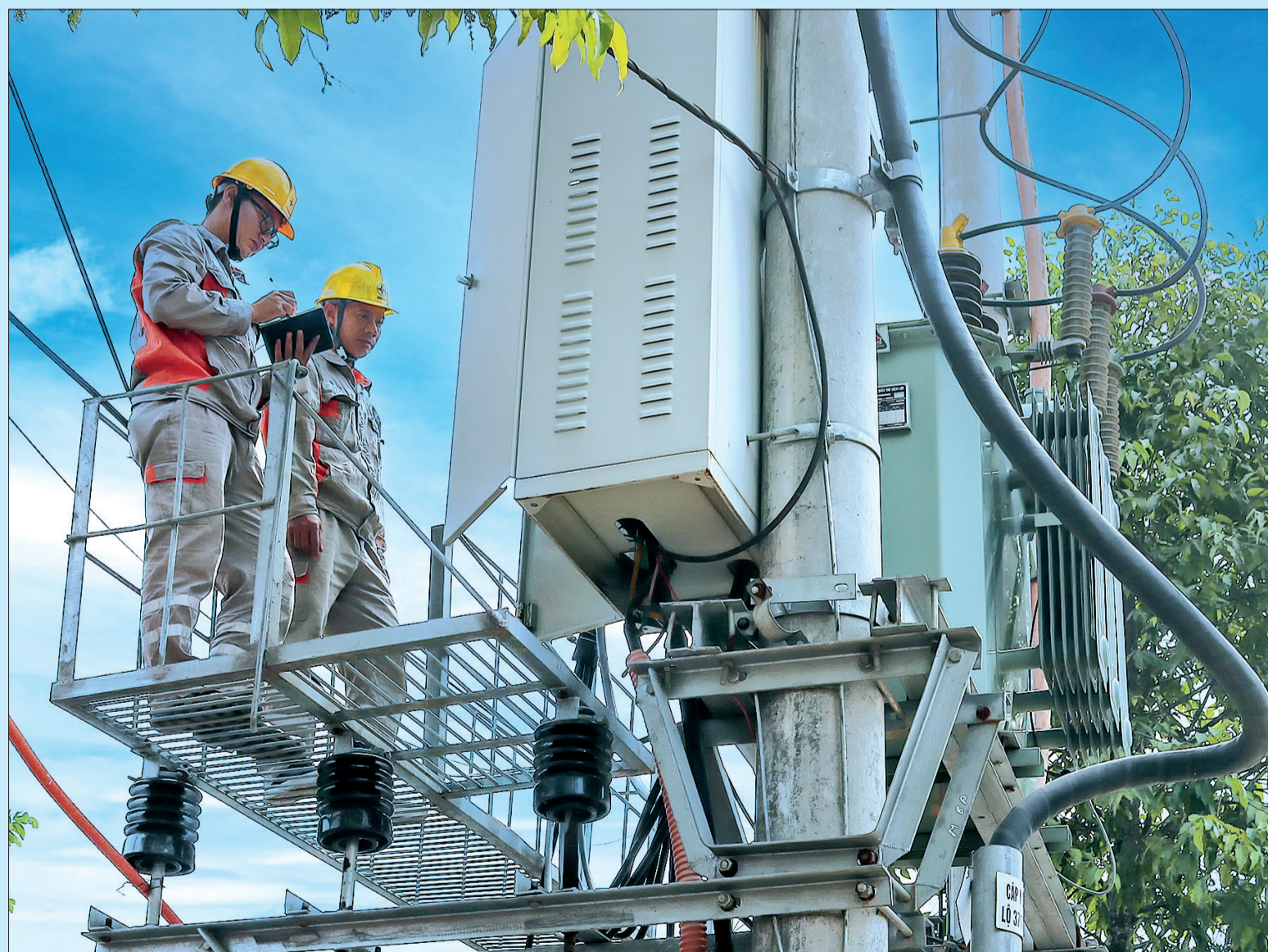
Công nhân Điện lực thành phố Thái Bình kiểm tra, sửa chữa lưới điện.
