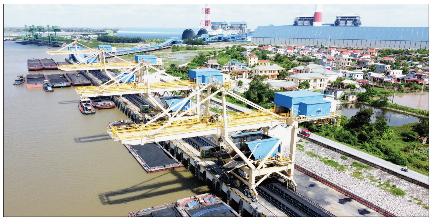
Cảng than của Nhà máy nhiệt điện Thái Bình 2.
