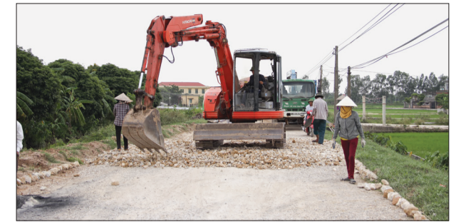
Thi công đường ĐH.78 đoạn từ dốc An Lộng đến UBND xã Quỳnh Hoàng (Quỳnh Phụ).
