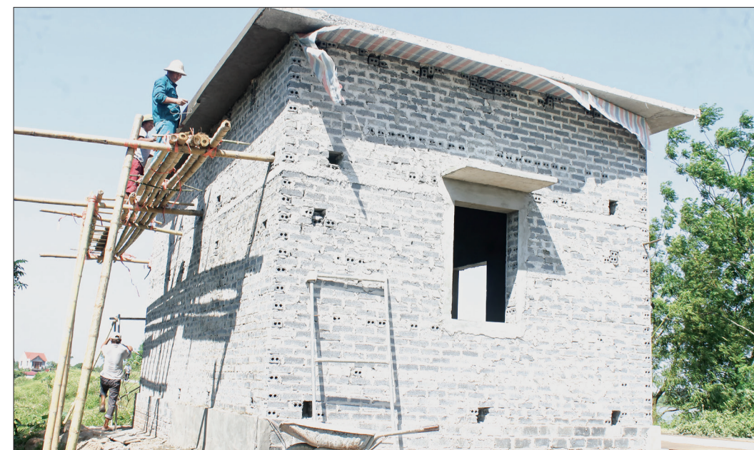
Điểm canh đê Ngô Xá (xã Nguyễn Xá, huyện Vũ Thư) được đầu tư xây mới.
