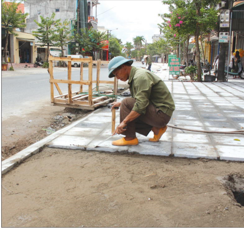
Thị trấn Tiên Hải lát lại vỉa hè trên tuyến đường trung tâm.
