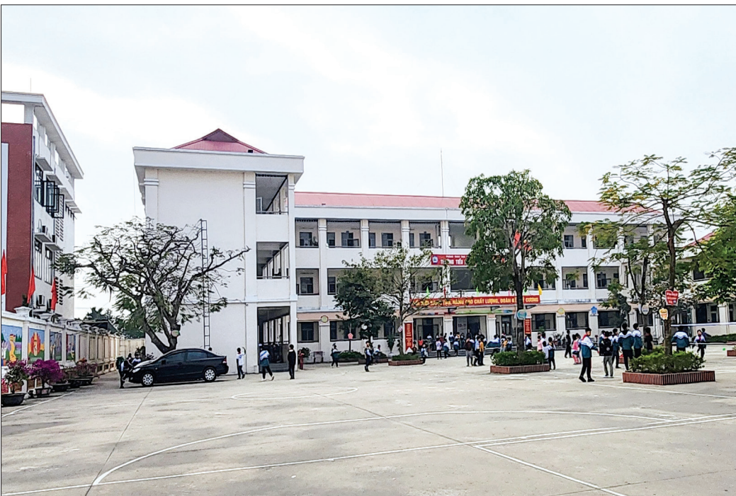
Trường Tiểu học An Ninh (Tiền Hải) được đầu tư xây dựng hiện đại.
