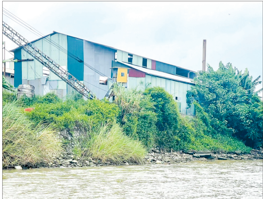
Công trình vi phạm gần 10 năm chưa được xử lý.
