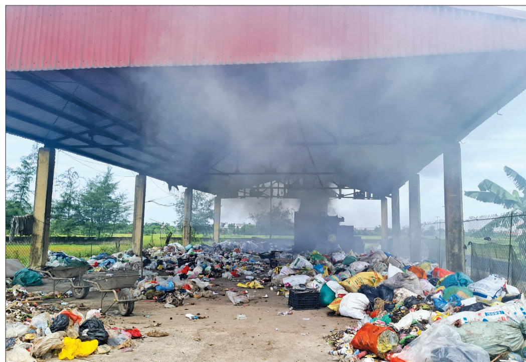
Lò đốt rác thải xã Bình Thanh (Kiến Xương) xuống cấp, khói đen tỏa khắp khu vực.
