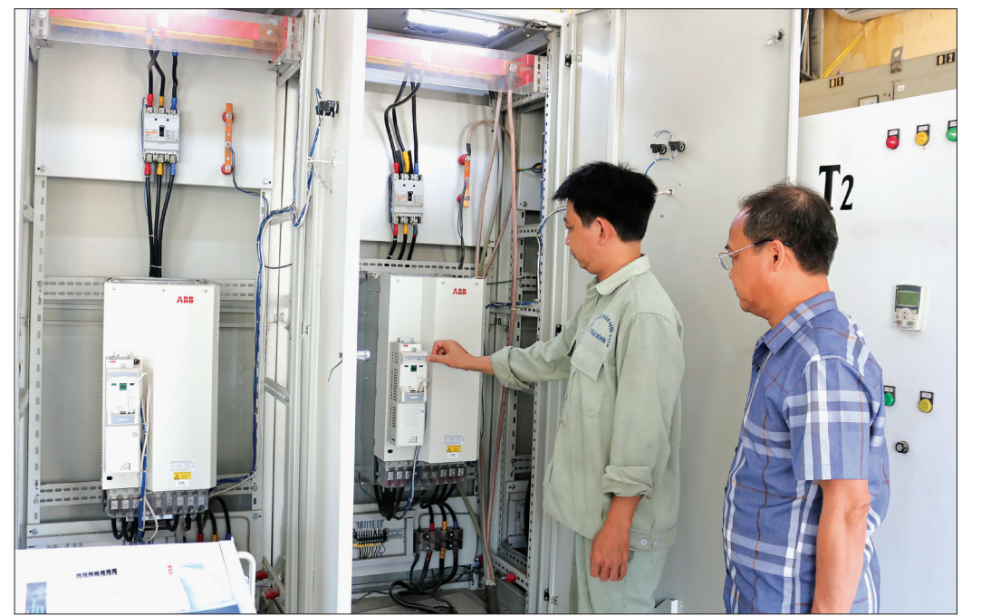
Sử dụng thiết bị biến tần giúp Công ty Cổ phần Nước sạch Thái Bình tiết kiệm 230 triệu đồng/năm tiền điện.
