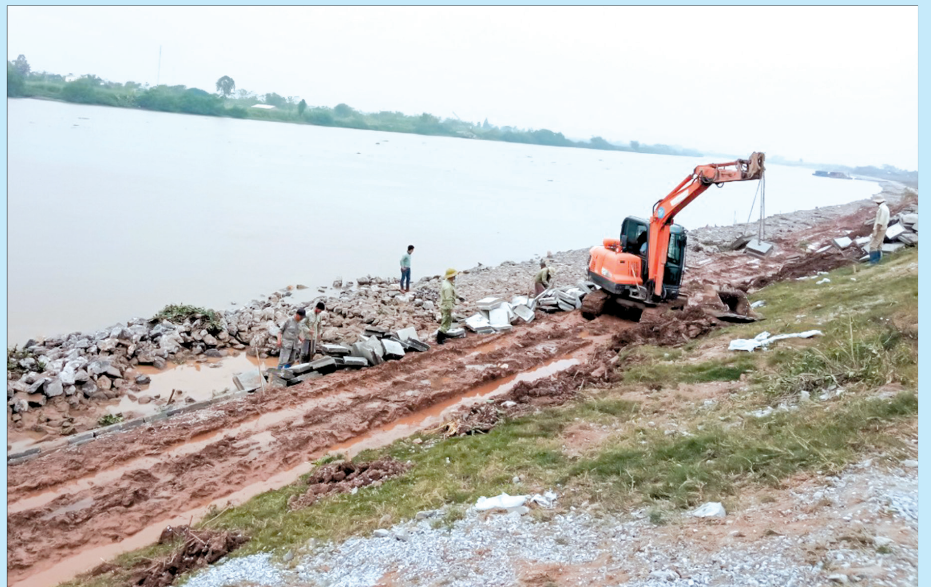
Thi công kè chống sạt lở bờ, bãi sông Trà Lý, đoạn từ K46+520 đến K46+650 và đoạn từ K47+200 đến K48+000 (xã Thái Phúc, huyện Thái Thụy).
