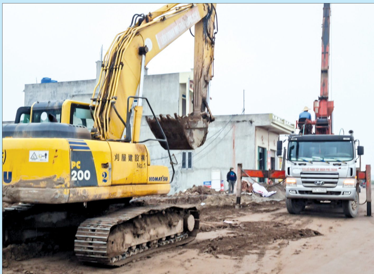
Tuyến đường 221A cơ bản hoàn thành công tác giải phóng mặt bằng.
