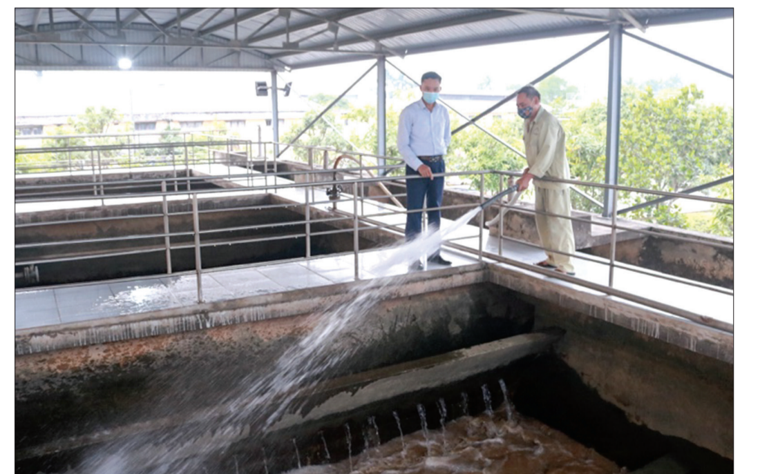
Công nhân Công ty Cổ phần Nước sạch Thái Bình tiến hành vệ sinh định kỳ bể sơ lắng.
