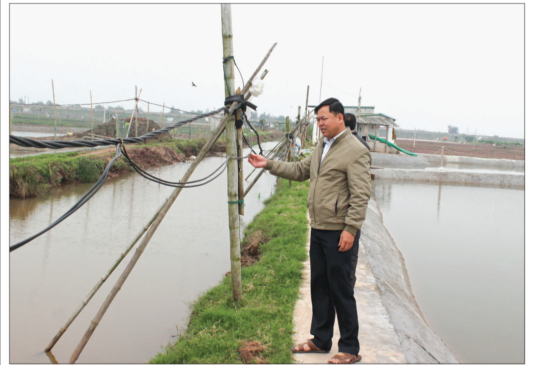
Hệ thống lưới điện bằng cọc tre tại vùng nuôi trồng thủy sản xã Đông Hải (Tiền Hải).
