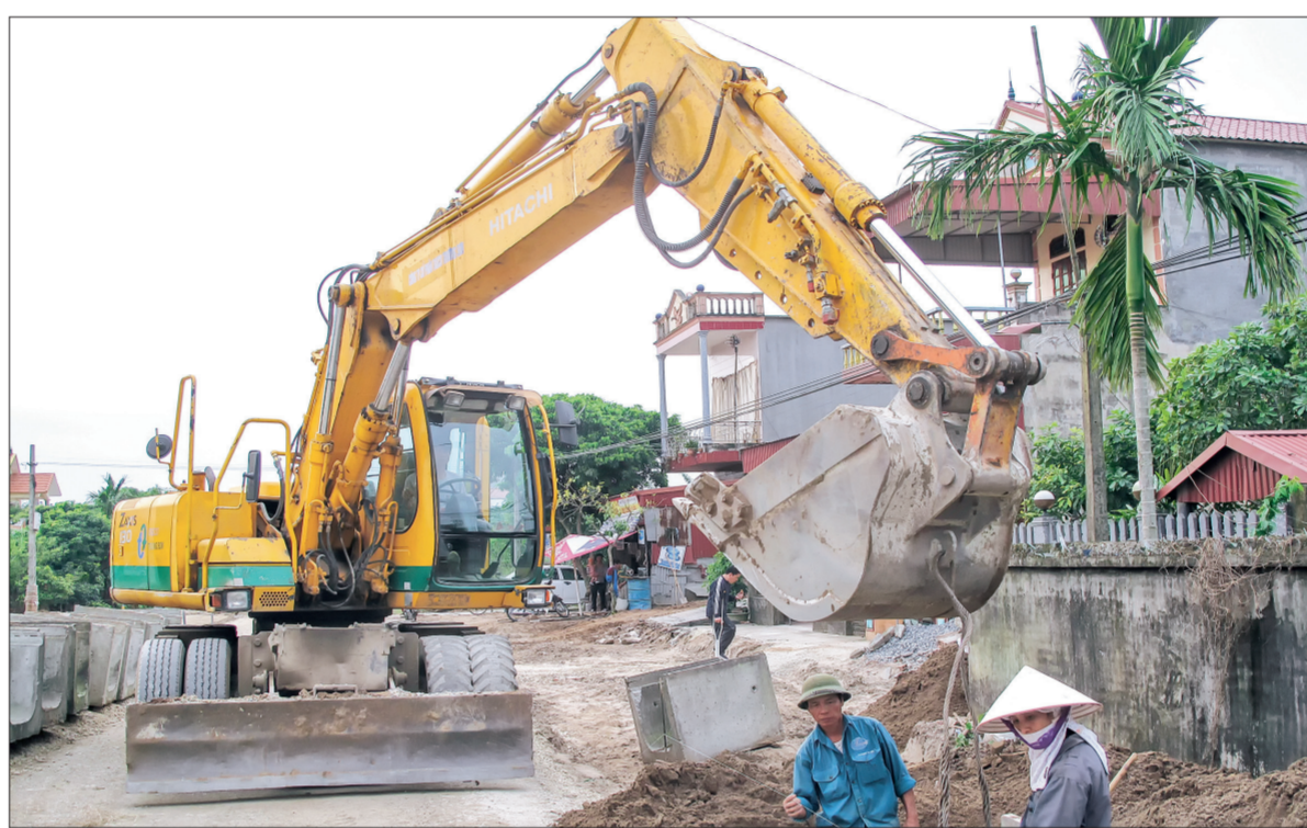
Những năm qua, tỉnh đã huy động nhiều nguồn lực đầu tư xây dựng các công trình phục vụ dân sinh.
