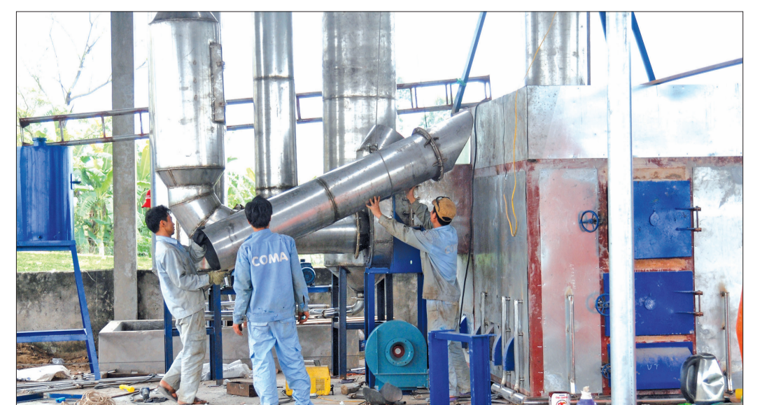
Xây dựng lò đốt rác liên xã Vũ Tây - An Bình tại xã Vũ Tây (Kiến Xương).
