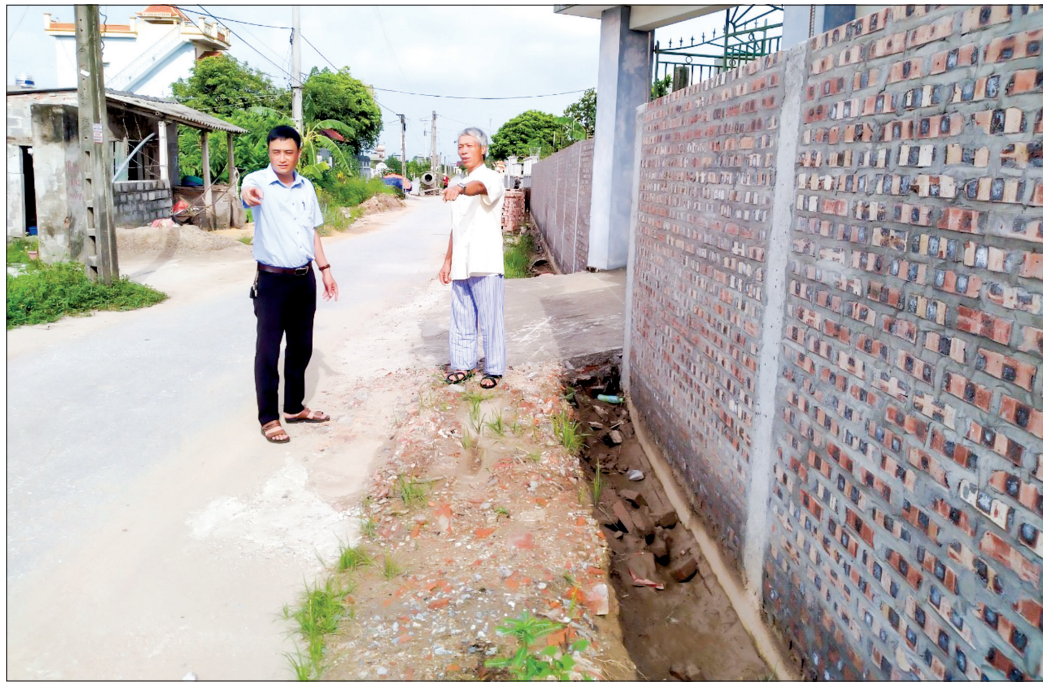
Ông Lưu Ngọc Lương (người bên phải), thôn Tống Xuyên, xã Thái Hưng (Hưng Hà) tự nguyện phá dỡ tường bao, cây cối bên giao mặt bằng để thi công tuyến đường qua địa bàn thôn.
