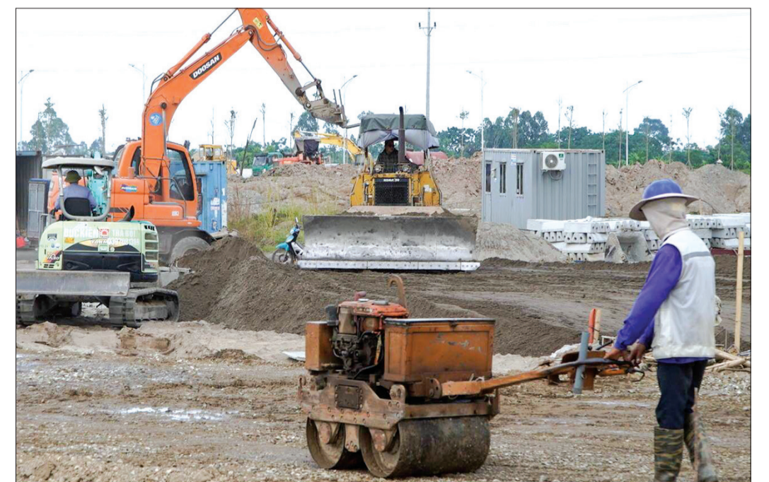
Xây dựng hạ tầng kỹ thuật khu công nghiệp Liên Hà Thái.
