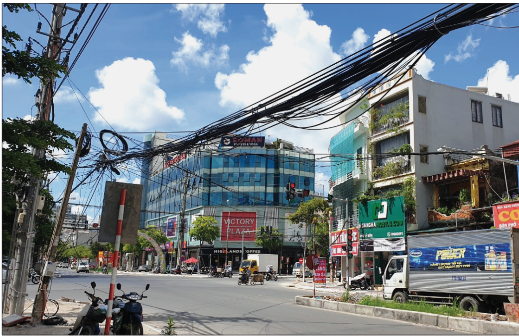
Tại tuyến đường Lý Bôn (thành phố Thái Bình), dây cáp viễn thông chằng chịt gây mất mỹ quan đô thị.
