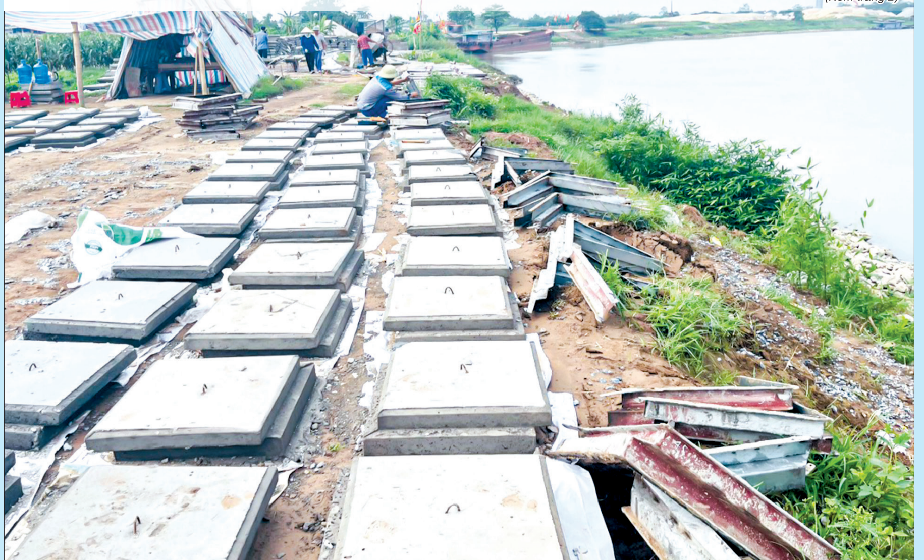
Dự án xử lý cấp bách kè Nhâm Lang đoạn từ K11+300 đến K11+800 đê hữu Luộc.
