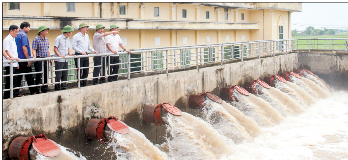
Đoàn công tác kiểm tra công tác tiêu thoát nước tại trạm bơm Lich Bài (Kiến Xương).
