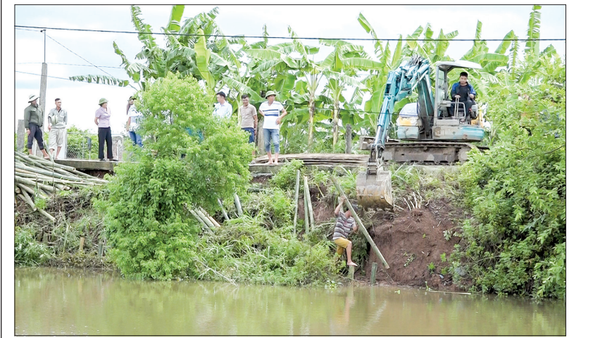
Gia cố khu vực sạt lở.
