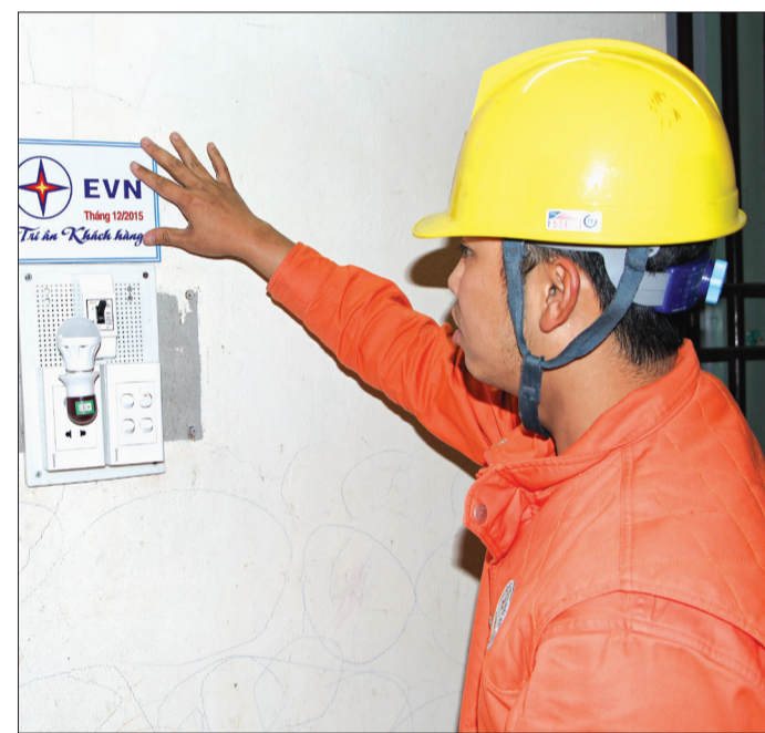
Nhiều hộ nghèo, gia đình chính sách được Công ty Điện lực Thái Bình lắp đặt, thay thế dây dẫn sau công tơ, bóng điện, bóng đèn tiết kiệm điện.
