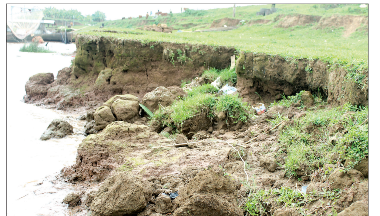
Hoạt động khai thác cát tràn lan làm bãi sông sạt lở vào sát chân đê bồi xã Việt Hùng.
