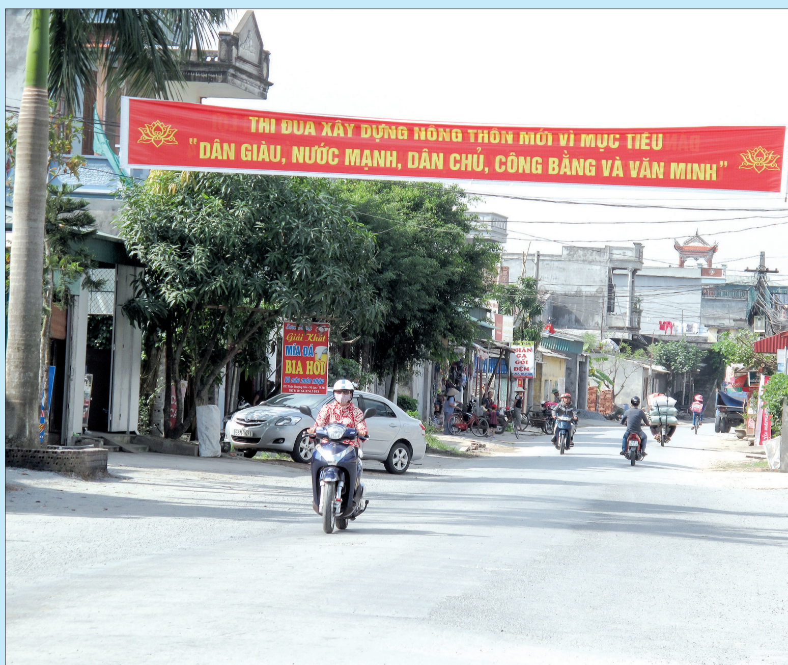
Đường giao thông nông thôn được cứng hóa.
