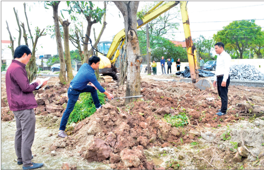
Đo đạc, kiểm đếm tại dự án tuyến đường bộ ven biển đoạn qua huyện Tiền Hải.
