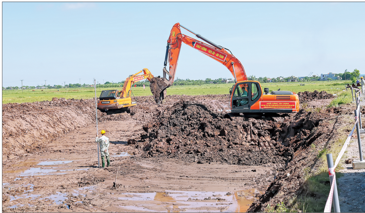
Nhà thầu thi công các đoạn đã giải phóng mặt bằng.
