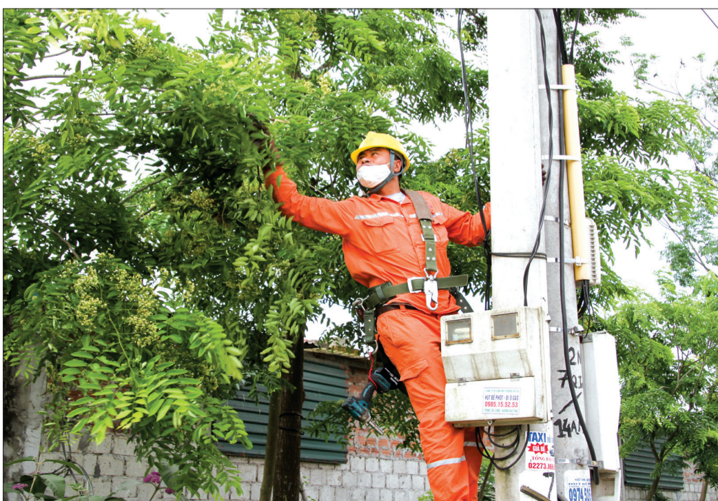
Nhân viên Điện lực Quỳnh Phụ xử lý sự cố lưới điện do thả điều gây ra.
