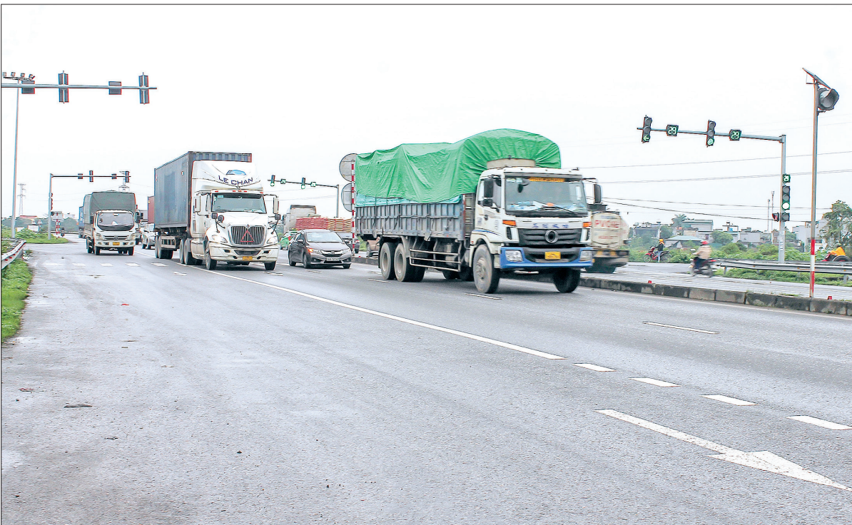
Ngã tư giao cắt giữa tuyến đường Tân Hòa - thị trấn Vũ Thư với đường tránh S1 (tại xã Minh Quang) là một trong những điểm thường xuyên xảy ra tai nạn giao thông nghiêm trọng.
