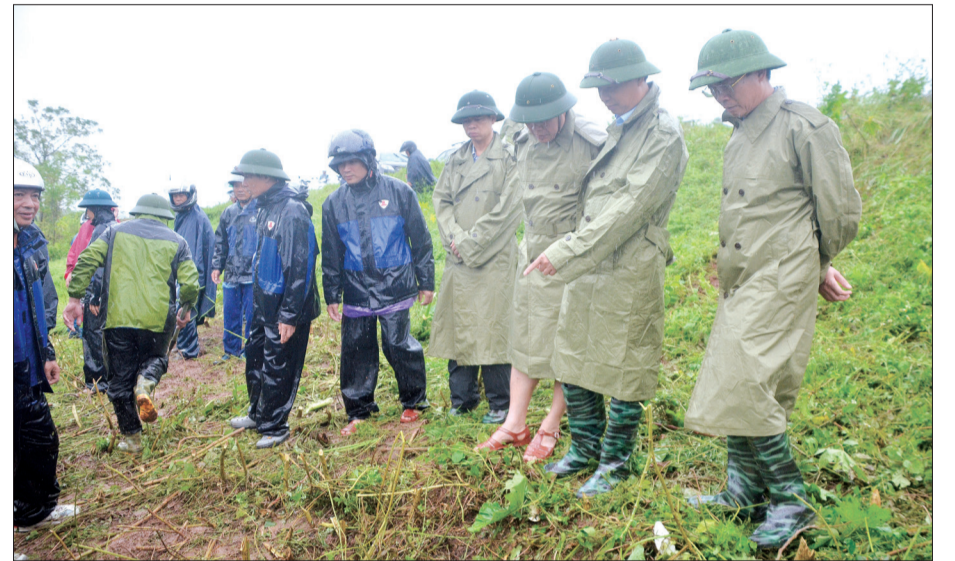
Đồng chí Hoàng Thái Phúc, Ủy viên Ban Thường vụ, Trưởng ban Nội chính Tỉnh ủy kiểm tra, chỉ đạo xử lý sự cố mạch sủi tại tuyến đê xã Quỳnh Hoàng (Quỳnh Phụ).
