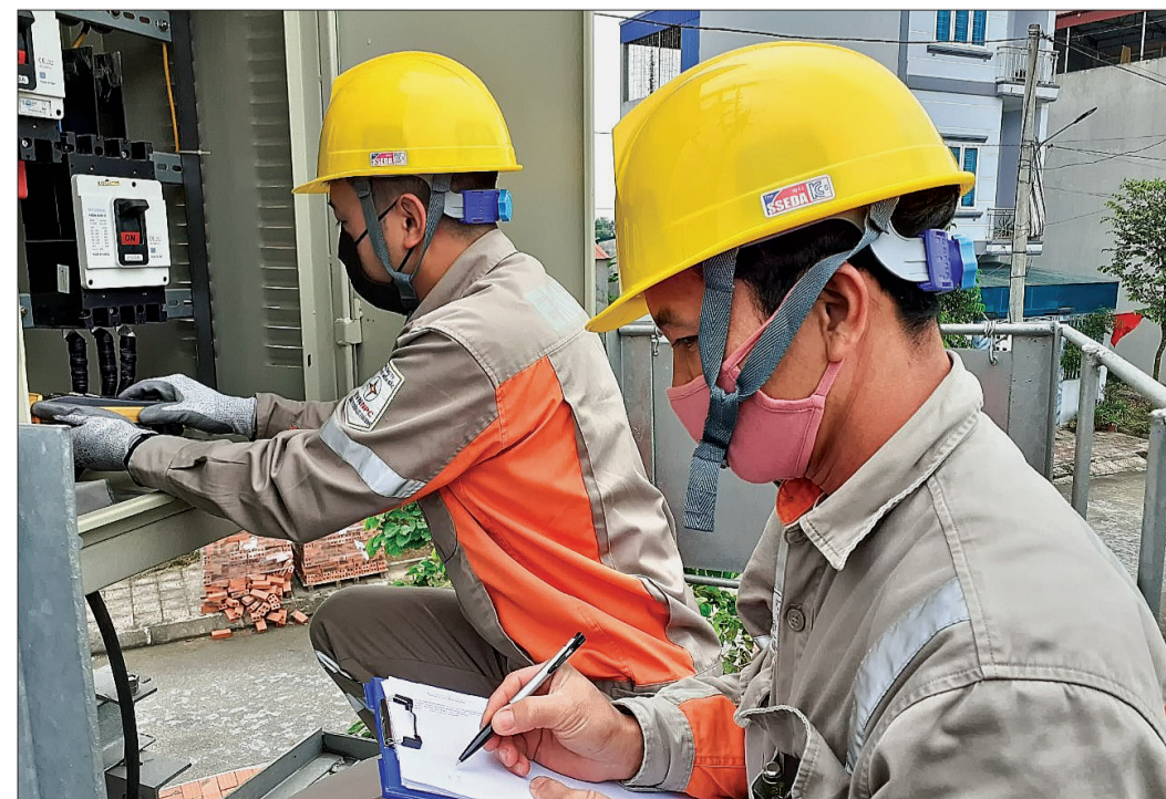
Công nhân Điện lực Hưng Hà kiểm tra, sửa chữa lưới điện cho khách hàng.
