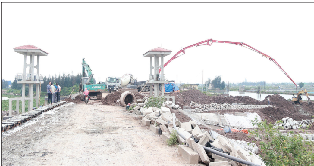
Thi công công trình cống Thoái thuộc tuyến đê biển 5, địa phận xã Nam Cường (Tiền Hải).
