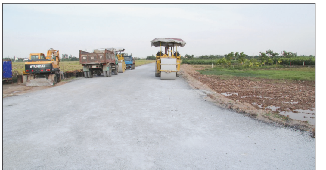
Tuyến đường ĐH.64 thuộc địa phận xã Hòa Bình đang trong giai đoạn rải nhựa asphalt.
