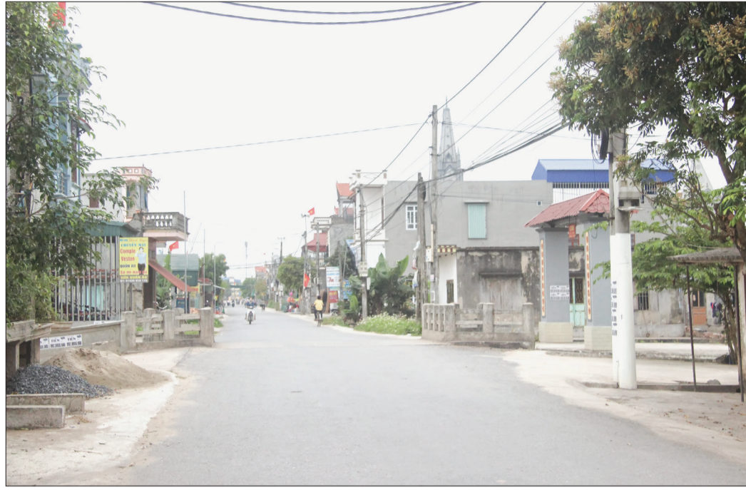
Đường giao thông xã Đông Cơ (Tiền Hải) được cứng hóa.
