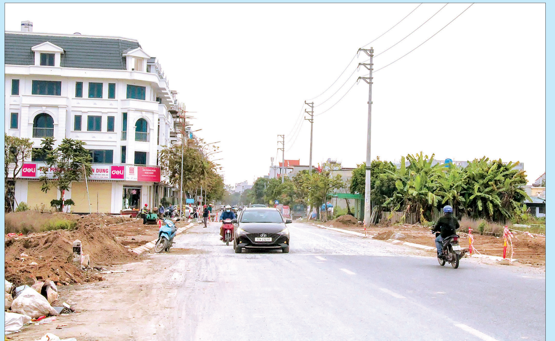
100m đường Song An, Trung An (Vũ Thư) nối với đường Đoàn Khuê (thành phố Thái Bình) đang được khẩn trương thi công, hoàn thiện.
