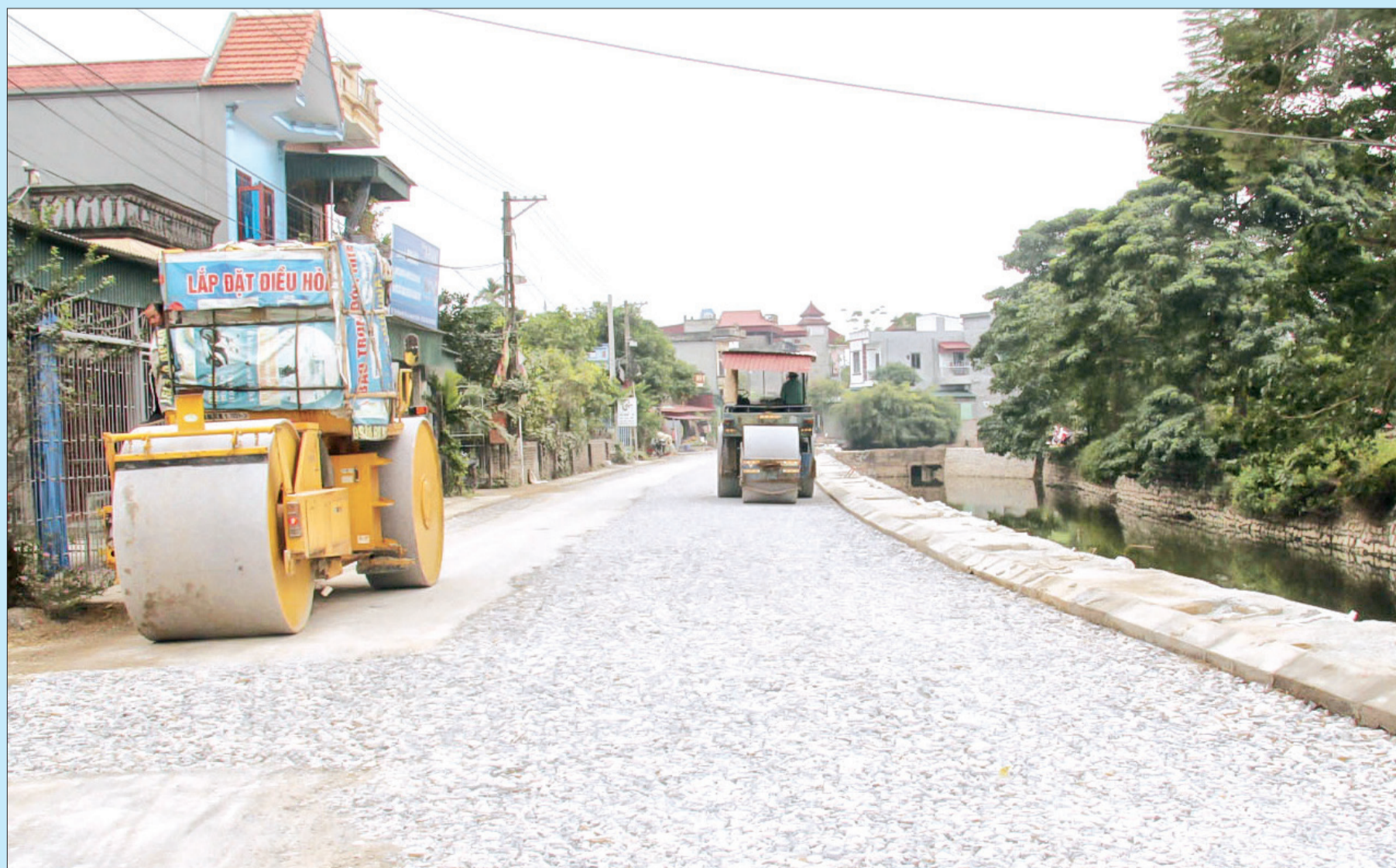
Tuyến đường ĐH.67 đoạn qua xã Phúc Khánh (Hung Hà) dự kiến hoàn thành trước tết Nguyên đán Quý Mão 2023.
