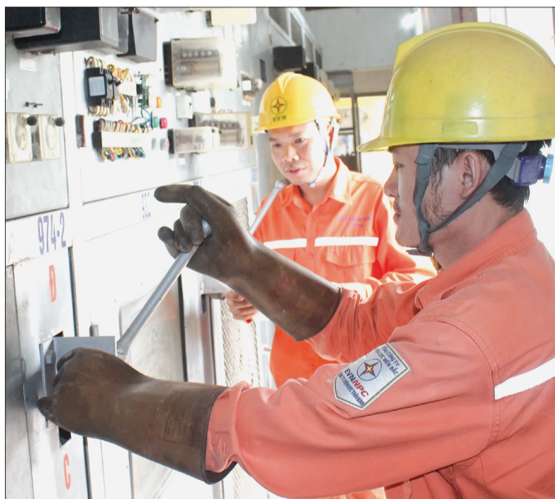
Công nhân Điện lực Quỳnh Phụ kiểm tra hệ thống trạm điện bảo đảm cung ứng điện ổn định, an toàn.
