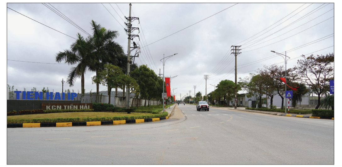
Khu công nghiệp Tiên Hải được đầu tư đồng bộ hạ tầng.
