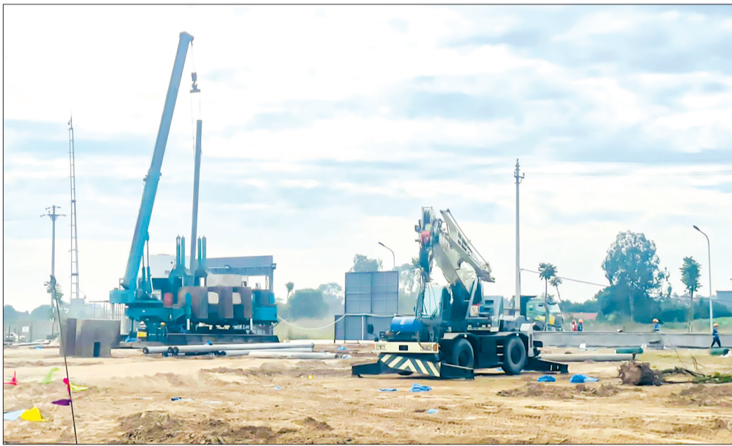
Công ty TNHH Snow Coast (Việt Nam), CCN Thống Nhất đẩy nhanh tiến độ thi công nhà máy.
