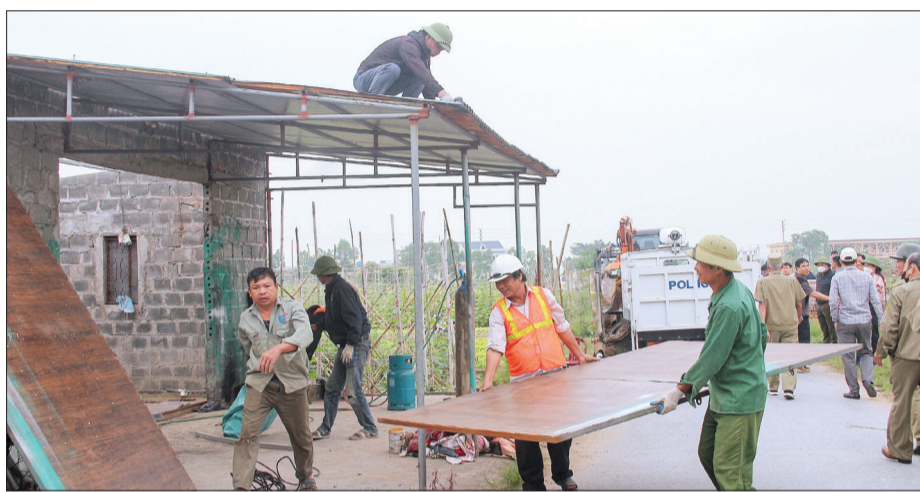
Lực lượng chức năng hỗ trợ hộ gia đình tự nguyện tháo dỡ tài sản xây dựng trên đất thu hồi.
