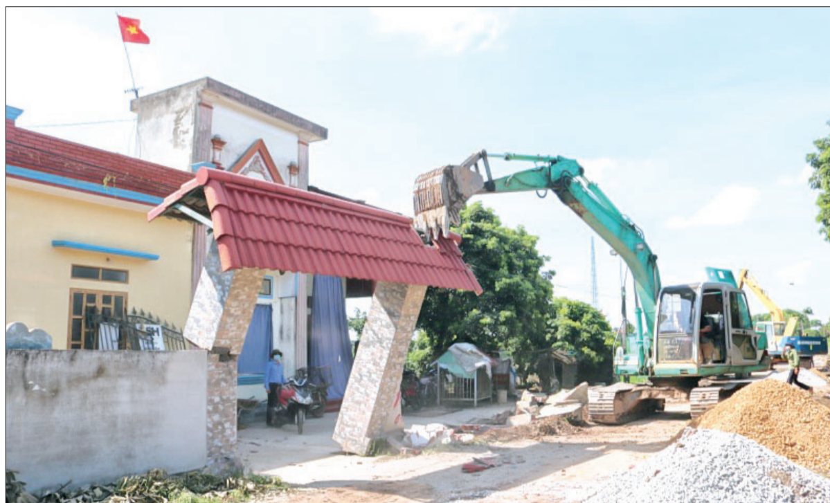
Người dân xã Quỳnh Ngọc (Quỳnh Phụ) tự nguyện tháo dỡ công trình hiến đất làm đường.
