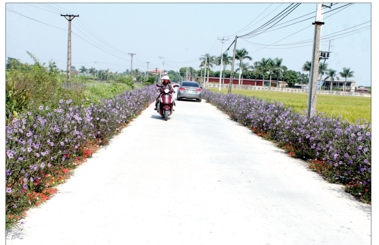
Đường giao thông nông thôn mới xã Việt Hùng (Vũ Thư).
