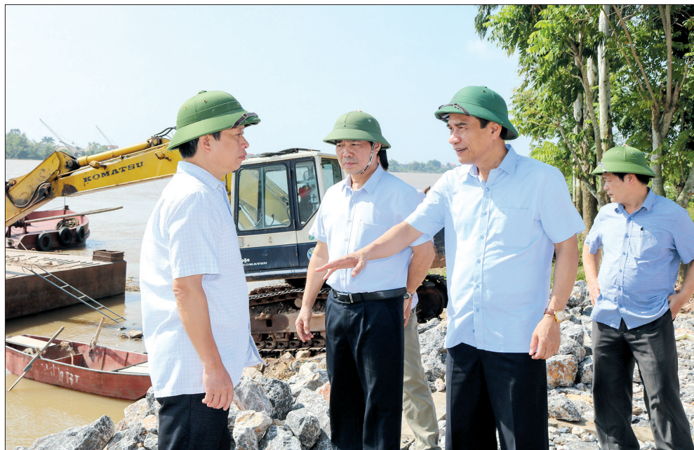
Đông chí Đặng Trọng Thăng, Phó Bí thư thường trực Tỉnh ủy, Chủ tịch UBND tỉnh chỉ đạo đơn vị thi công kè Tống Thỏ (xã Đông Mỹ, thành phố Thái Bình) thực hiện các phương án bảo vệ công trình.
