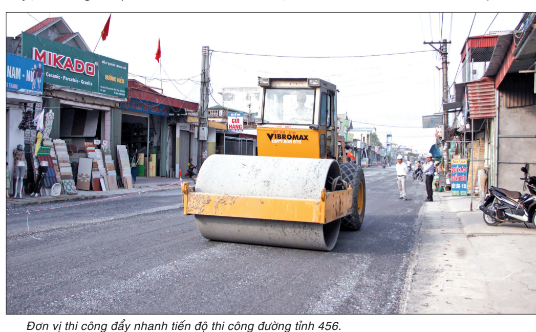
Đơn vị thi công đẩy nhanh tiến độ thi công đường tỉnh 456.
