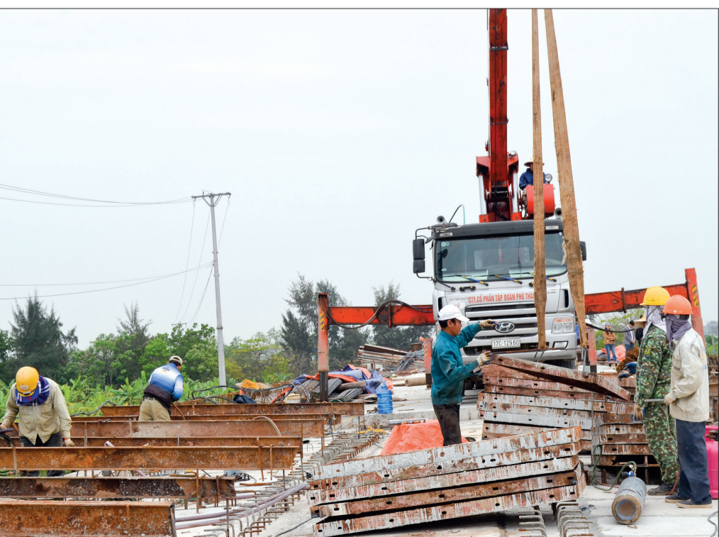
Thi công đường 221A đoạn qua xã Tây Tiến (Tiên Hải).
