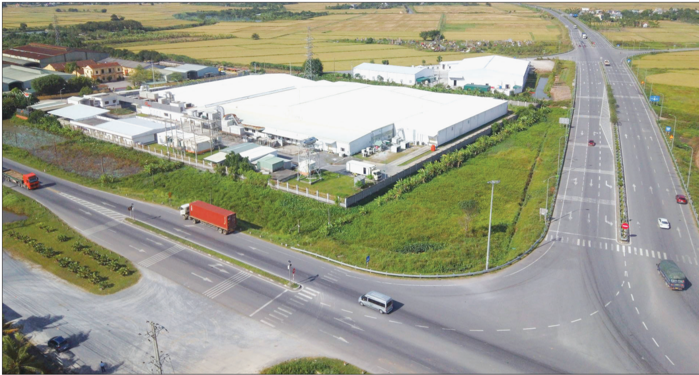
Hạ tầng giao thông và hạ tầng các khu công nghiệp, cụm công nghiệp trên địa bàn tỉnh bảo đảm đồng bộ, hiện đại đáp ứng nhu cầu đầu tư, phát triển của các doanh nghiệp.
