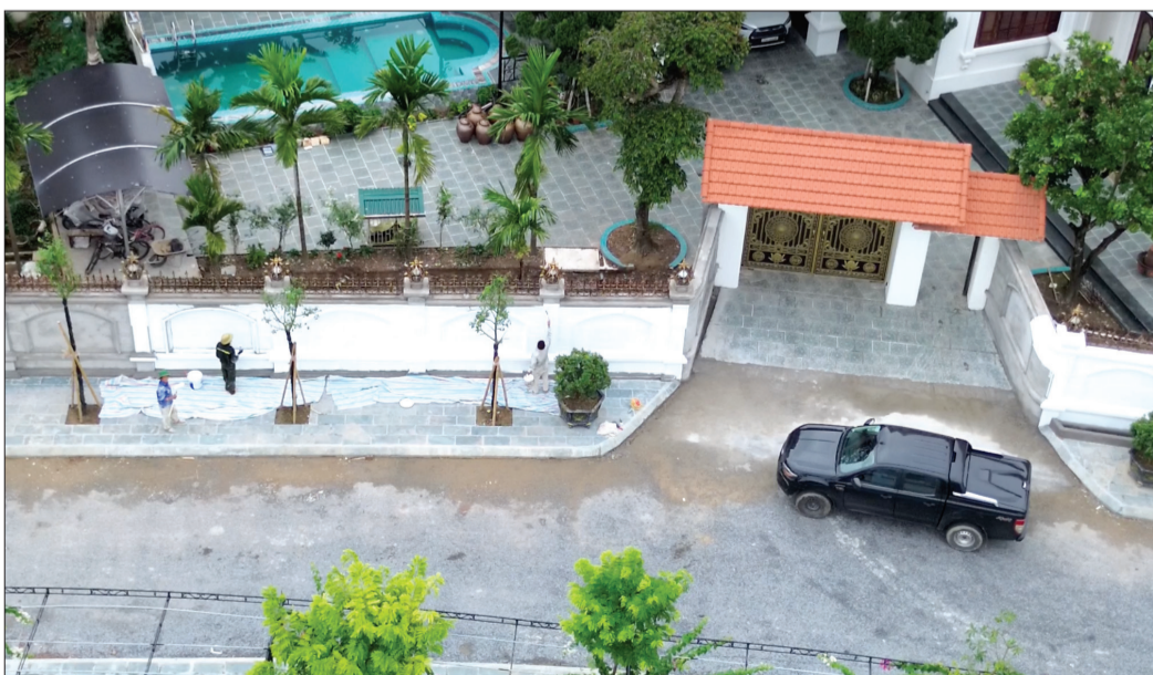
Mặc dù huyện Hưng Hà đã chỉ đạo thị trấn Hưng Hà yêu cầu tạm dừng thi công công trình nhưng gia đình ông Phạm Tiến Văn vẫn không chấp hành.
