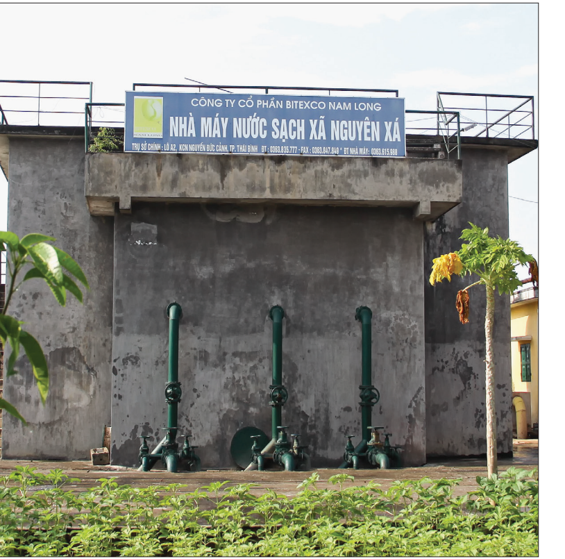
Nhà máy nước sạch Nguyễn Xá.
