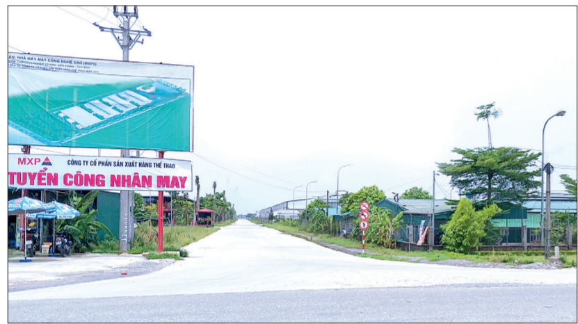
Hạ tầng cụm công nghiệp Vũ Ninh (Kiến Xương) được đầu tư đồng bộ tạo thuận lợi cho các doanh nghiệp đầu tư sản xuất, kinh doanh.
