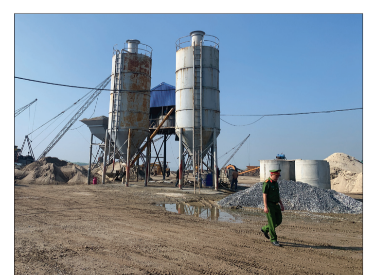
Tháo dỡ trạm trộn bê tông trái phép tại xã Việt Thuận sáng ngày 31/10.
