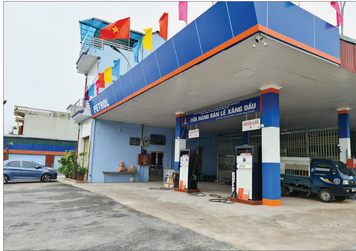
Cửa hàng xăng dầu của doanh nghiệp tư nhân Chúc Chiến (xã Dân Chủ, huyện Hưng Hà) xây dựng năm 2018 không có thủ tục đầu tư về xây dựng và đầu nối trái phép vào đường ĐT.452.
