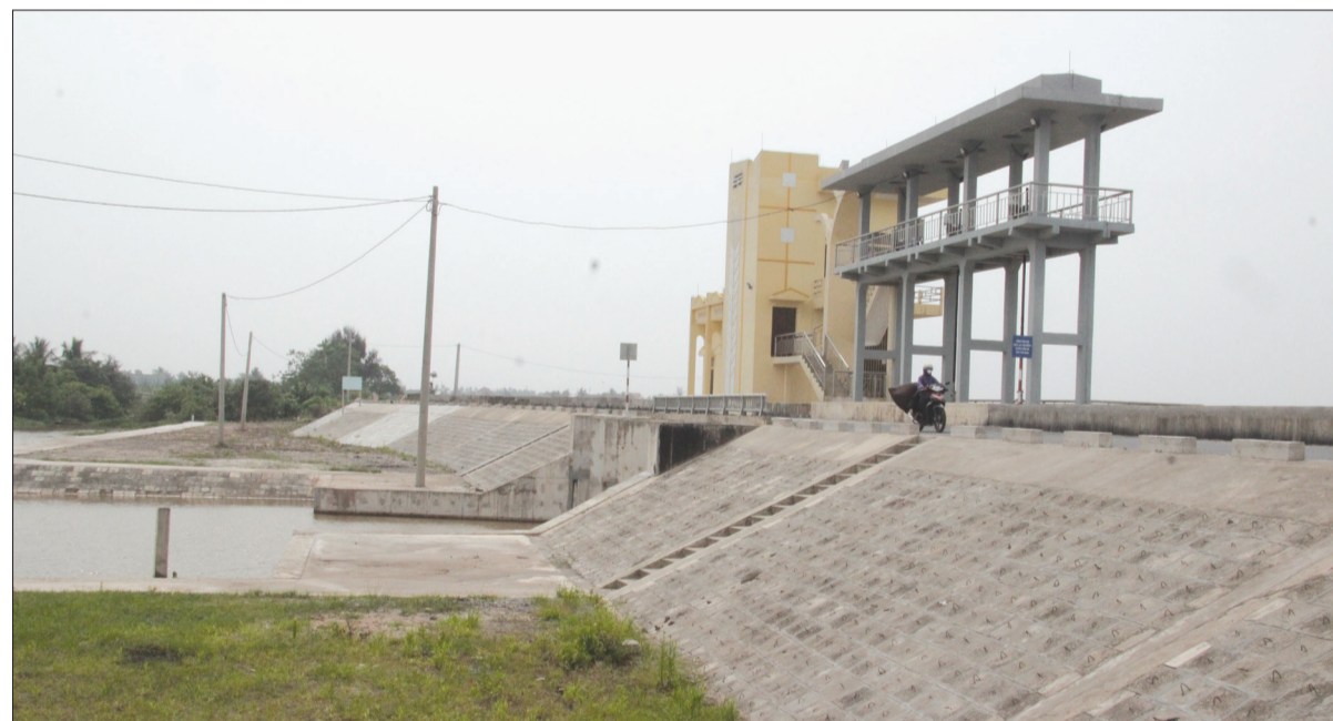
Cống tâm cửa được xây dựng bảo đảm công tác phòng, chống thiên tai trên địa bàn huyện Tiên Hải.
