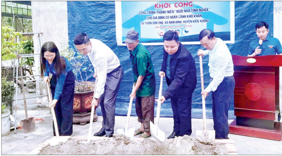
Khởi công xây dựng nhà tình nghĩa cho hộ có hoàn cảnh khó khăn ở xã Nam Bình (Kiến Xương).
