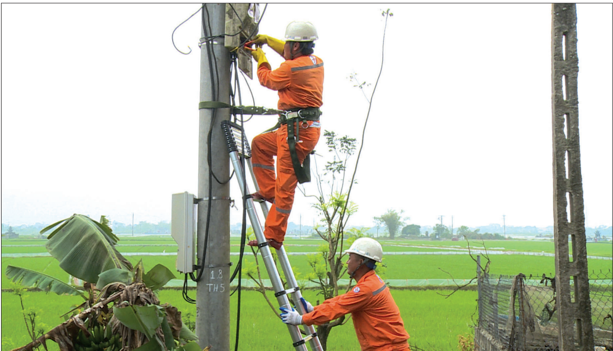
Công nhân Điện lực Vũ Thư sửa chữa lưới điện bảo đảm cấp điện an toàn, ổn định.
